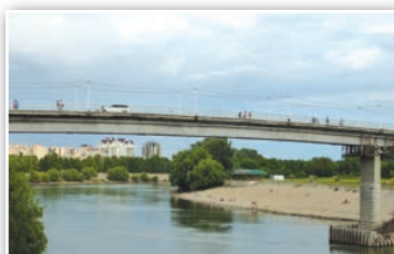
28. Мост через Днестр
