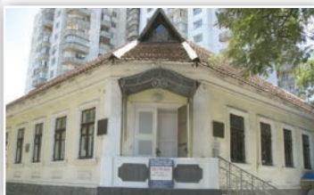
12. Военно-исторический музей штаба бригады Г.И. Котовского
