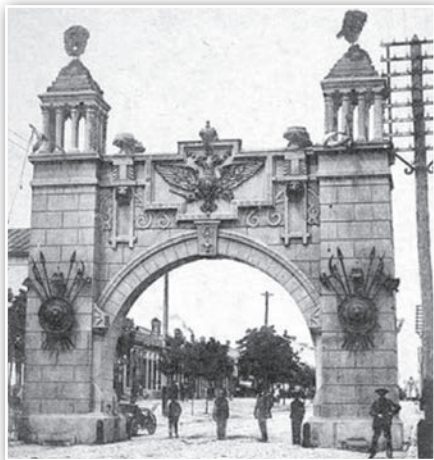
Кишинёвская арка, установленная в центре, на Бендерской улице
